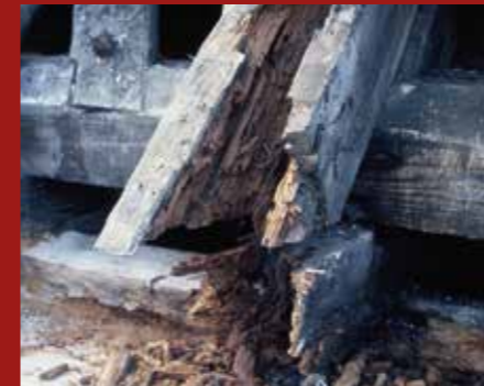
Dachstuhl verfault ...
