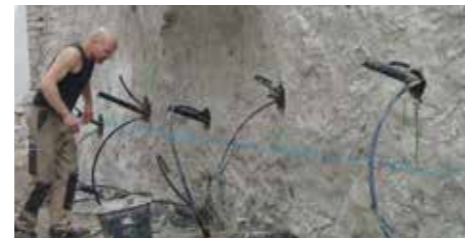
Verankerung der alten Stützmauer
