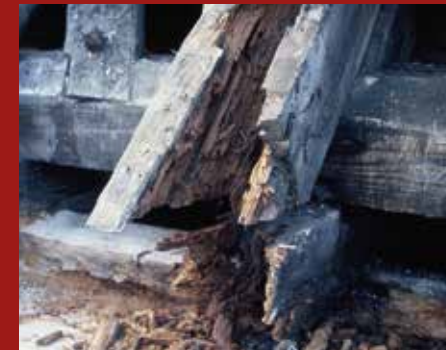
Dachstuhl verfault ...
