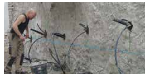
Verankerung der alten Stützmauer
